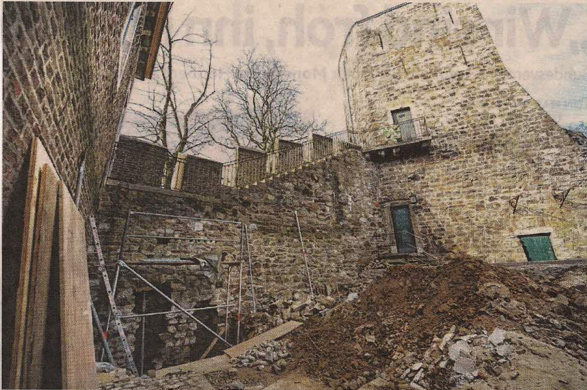
Ein Loch in der Mauer: Für einen erforderlichen Fluchtweg im künftigen Bürger- und Kulturzentrum Burg Frankenberg ist ein Durchbruch nötig. Foto: Harald Krömer
